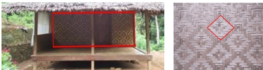
Gambar 3. (a) Sisi depan dinding; (b) Anyaman dinding
