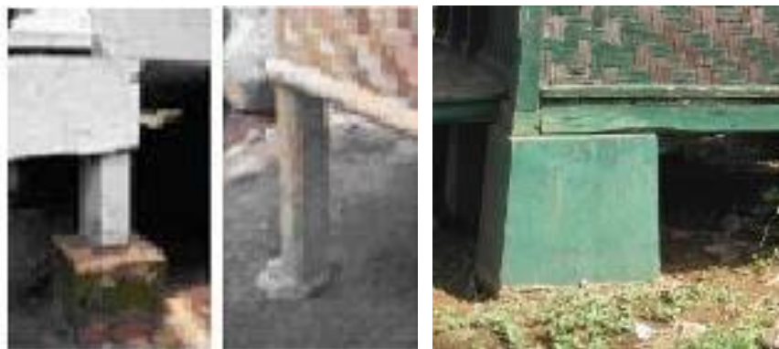
Gambar 6. Bentuk pondasi
